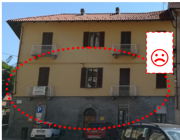
Rivestimento incongruo coinvolgente l'intero livello basamentale
