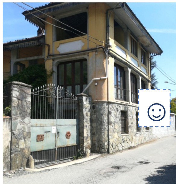
Esempio di rivestimento lapideo costituente carattere originario dell'edificio di matrice Liberty.
