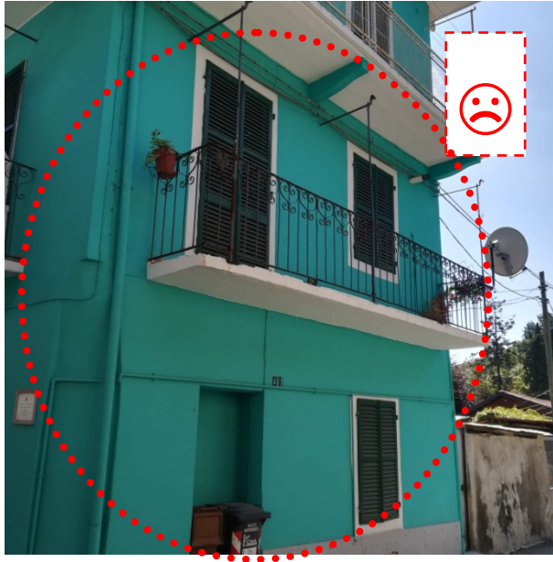
La tinta principale - eccessivamente satura - è stata applicata erroneamente anche ai modiglioni che sorreggono il balcone.
