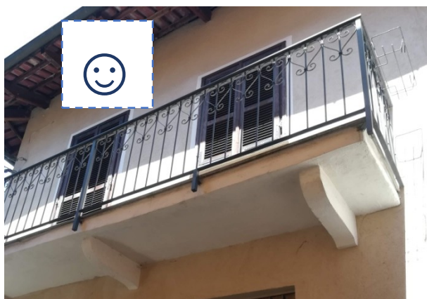
Parapetto fissato sul frontalino
