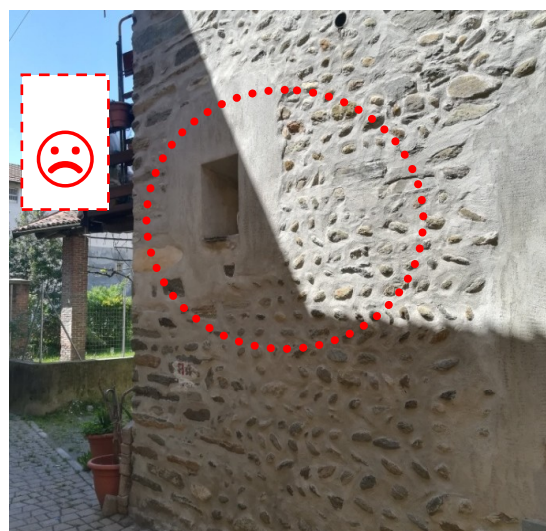
Esempio di tessitura muraria di bassa qualità, INADATTA alla finitura faccia a vista.
